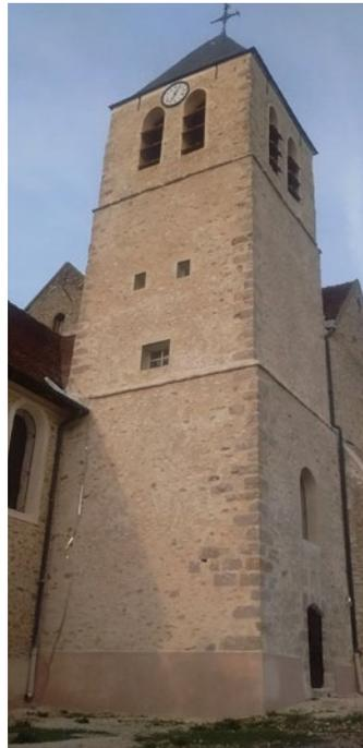
Les maçonneries du clocher étaient particulièrement dégradées et il était devenu urgent de le restaurer. La toiture en ardoise a été remaniée, les façades des côtés sud et ouest ont été intégralement refaites, les châssis des fenêtres ont été remplacés et un paratonnerre a été installé.
